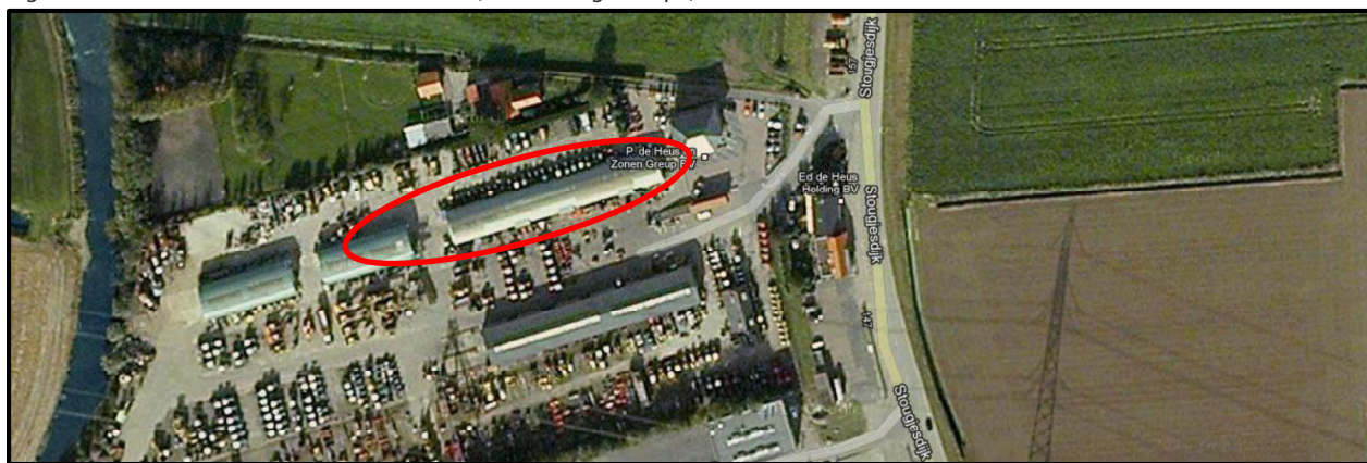
Figuur 2.1: Satellietfoto onderzoekslocatie (bron: Google Maps)
