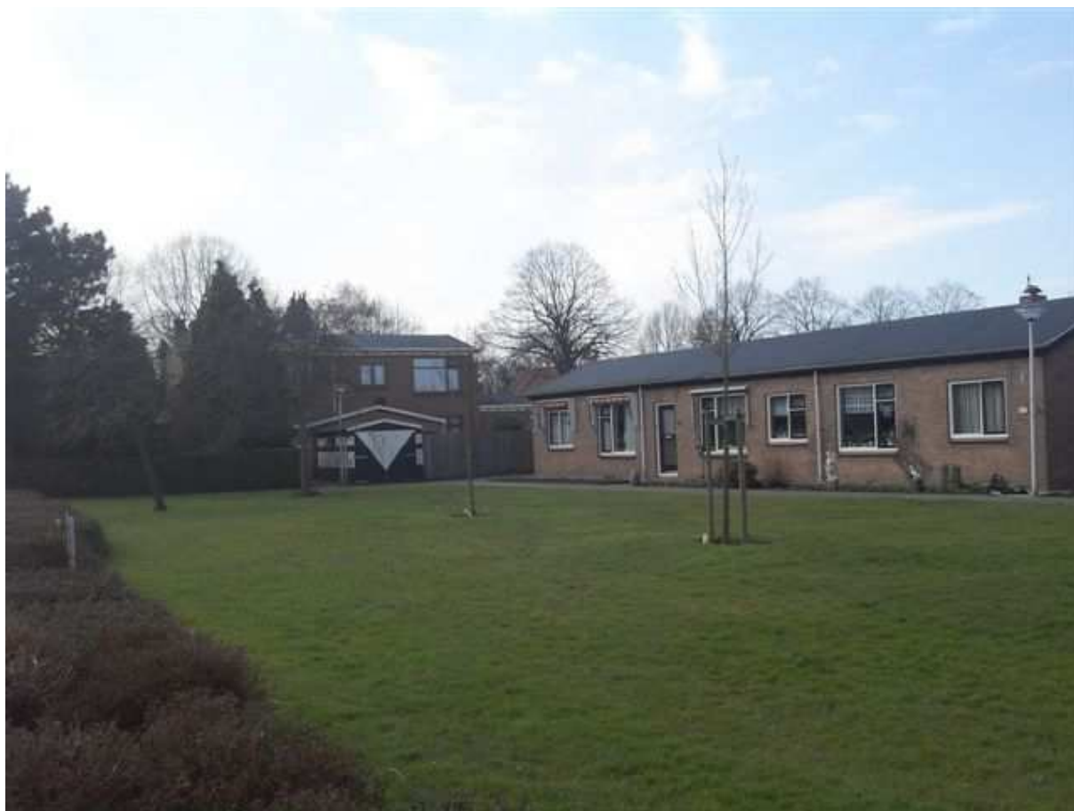
Foto 14: Burg. Groenevelt de Katerstraat te Maasdam
