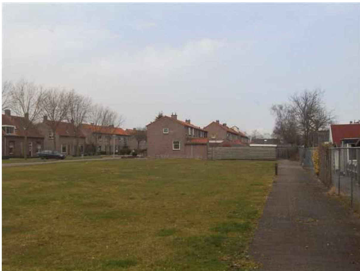
Foto 13: Burg. Groenevelt de Katerstraat te Maasdam
