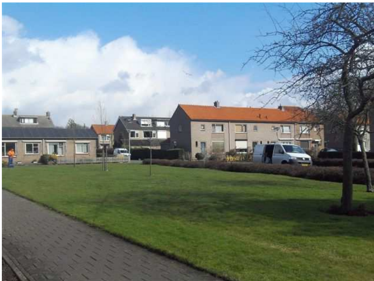
Foto 3: Burg. Groenevelt de Katerstraat te Maasdam
