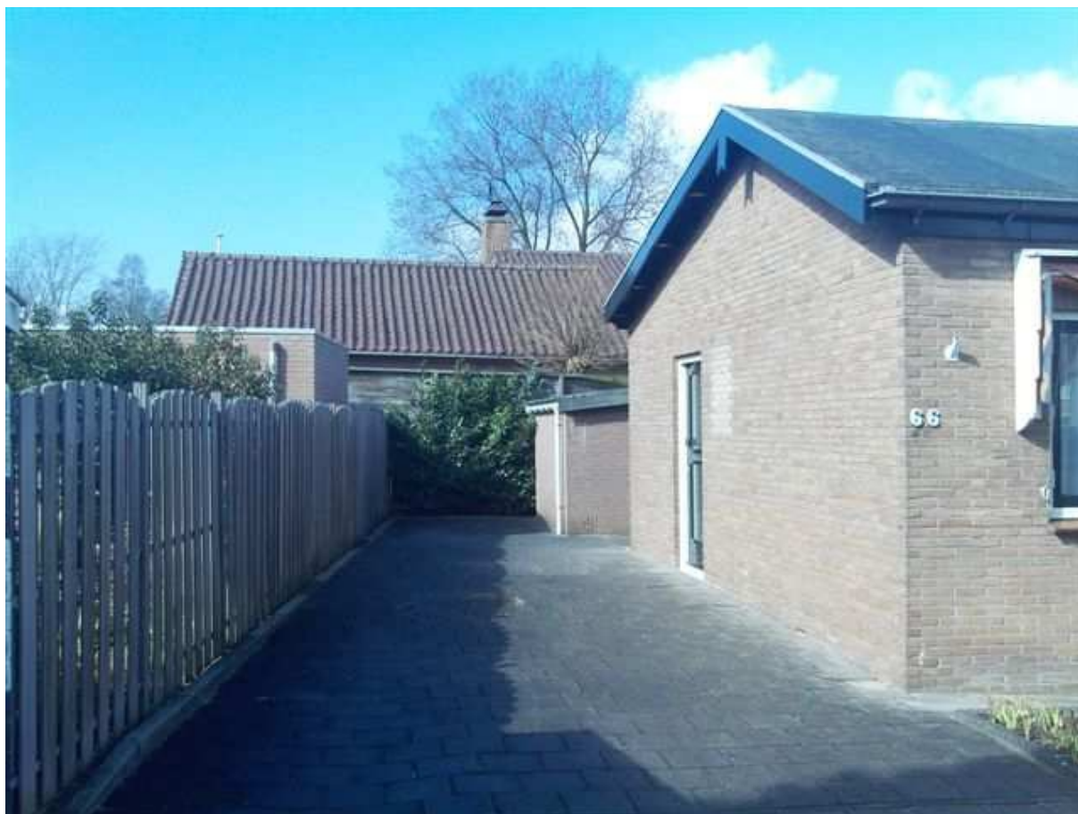
Foto 2: Burg. Groenevelt de Katerstraat te Maasdam
