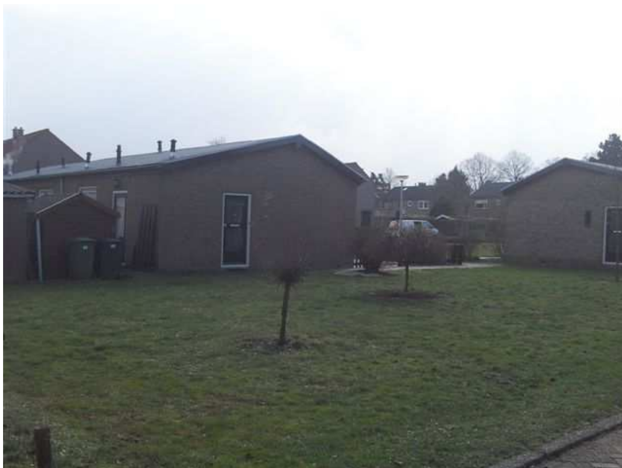
Foto 17: Burg. Groenevelt de Katerstraat te Maasdam
