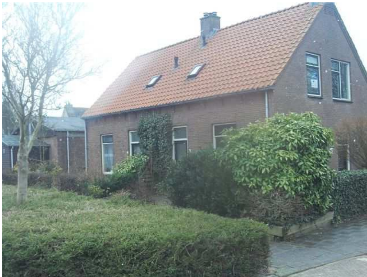
Foto 8: Burg. Groenevelt de Katerstraat te Maasdam
