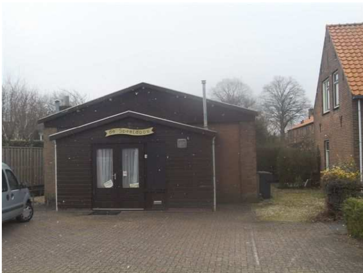
Foto 9: Burg. Groenevelt de Katerstraat te Maasdam
