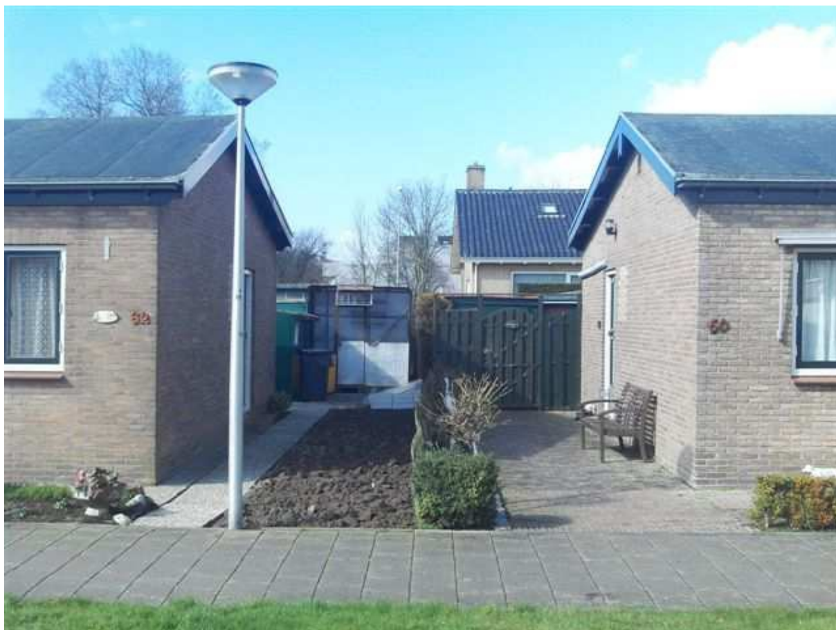
Foto 1: Burg. Groenevelt de Katerstraat te Maasdam
