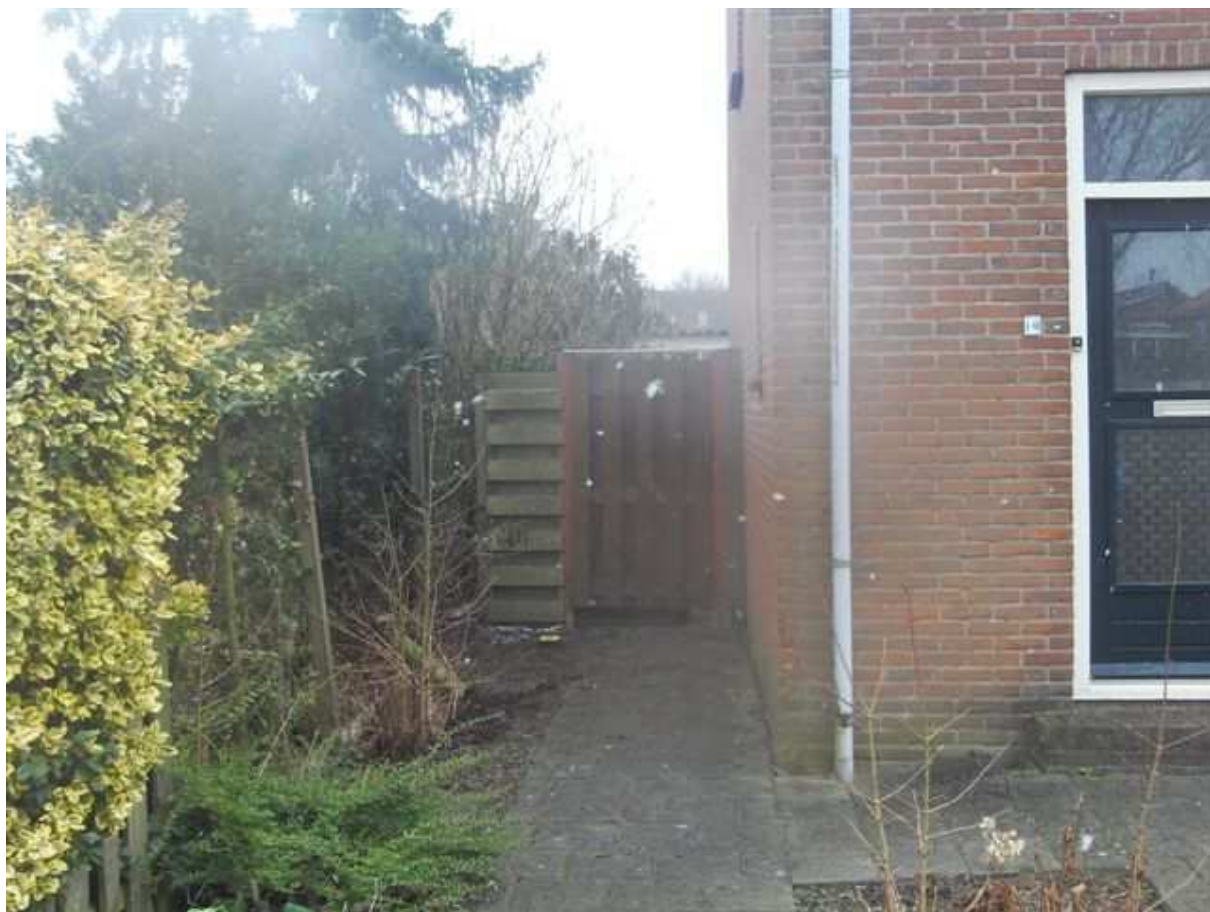
Foto 7: Burg. Groenevelt de Katerstraat te Maasdam
