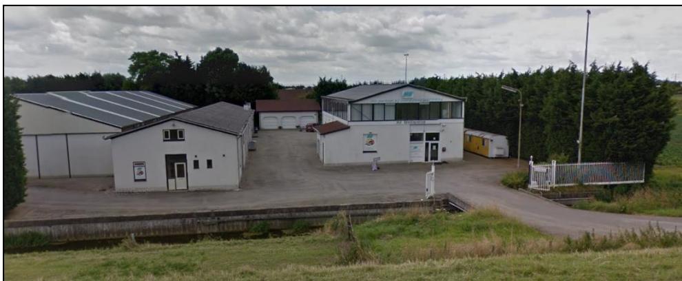
Bedrijfsbebouwing bedrijfsverzamelgebouw langs de Buitengorzendijk (Bron: Google Streetview).
