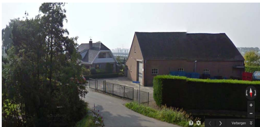
Figuur2 bestaande toestand
