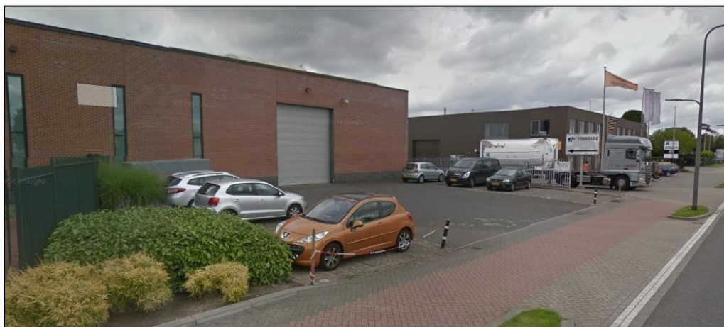
Bedrijfsbebouwing zonder kapconstructie (Boonsweg) (Bron: Google Streetview).
