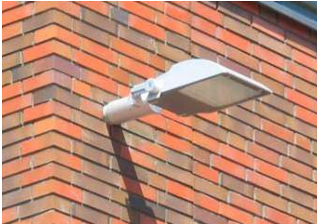
Verlichting aan gevel, detectie
