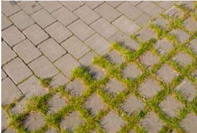
Betonkei; intensief en extensief gebruik
