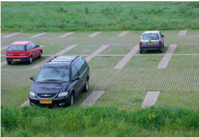
(piek-) parkeren op grasbeton
