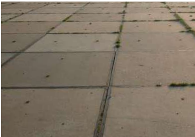
Betonplaten; hergebruik mogelijk
