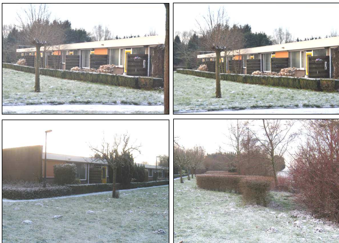
Figuur 3. Bestaand deel (noordwestelijk deel) Immanuëlhof te 's-Gravendeel.
