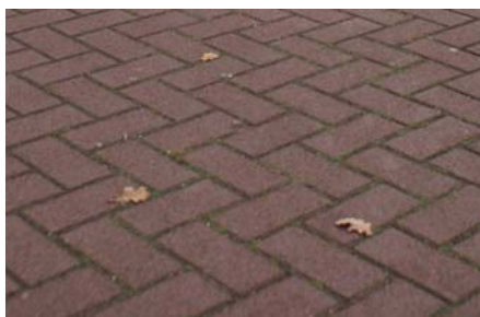
Rijbaan: Keiformaat klinkers keperverband - rood-bruin
