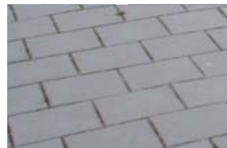
Voetpad: Tegels 30x30 halfsteensverband - grijs (eerste tegel langs rijbaan dikker ivm belasting)
