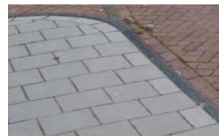
Opsluiting trottoir: Betonband antraciet
