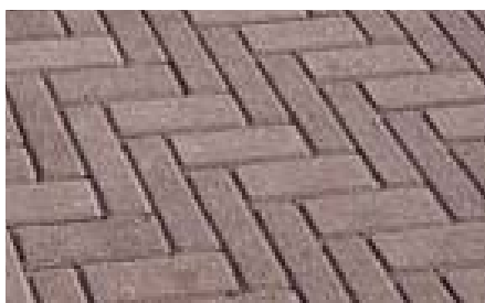
Parkeren: Dikformaat klinkers elleboogverband - rood-bruin
