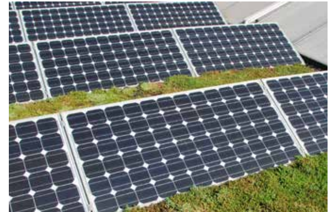
Combinatie sedumdak met zonnepanelen
