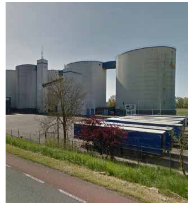
Bestaande silo's Suiker Unie
