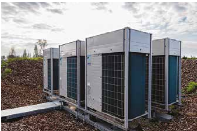
Luchtwarmtepompen
