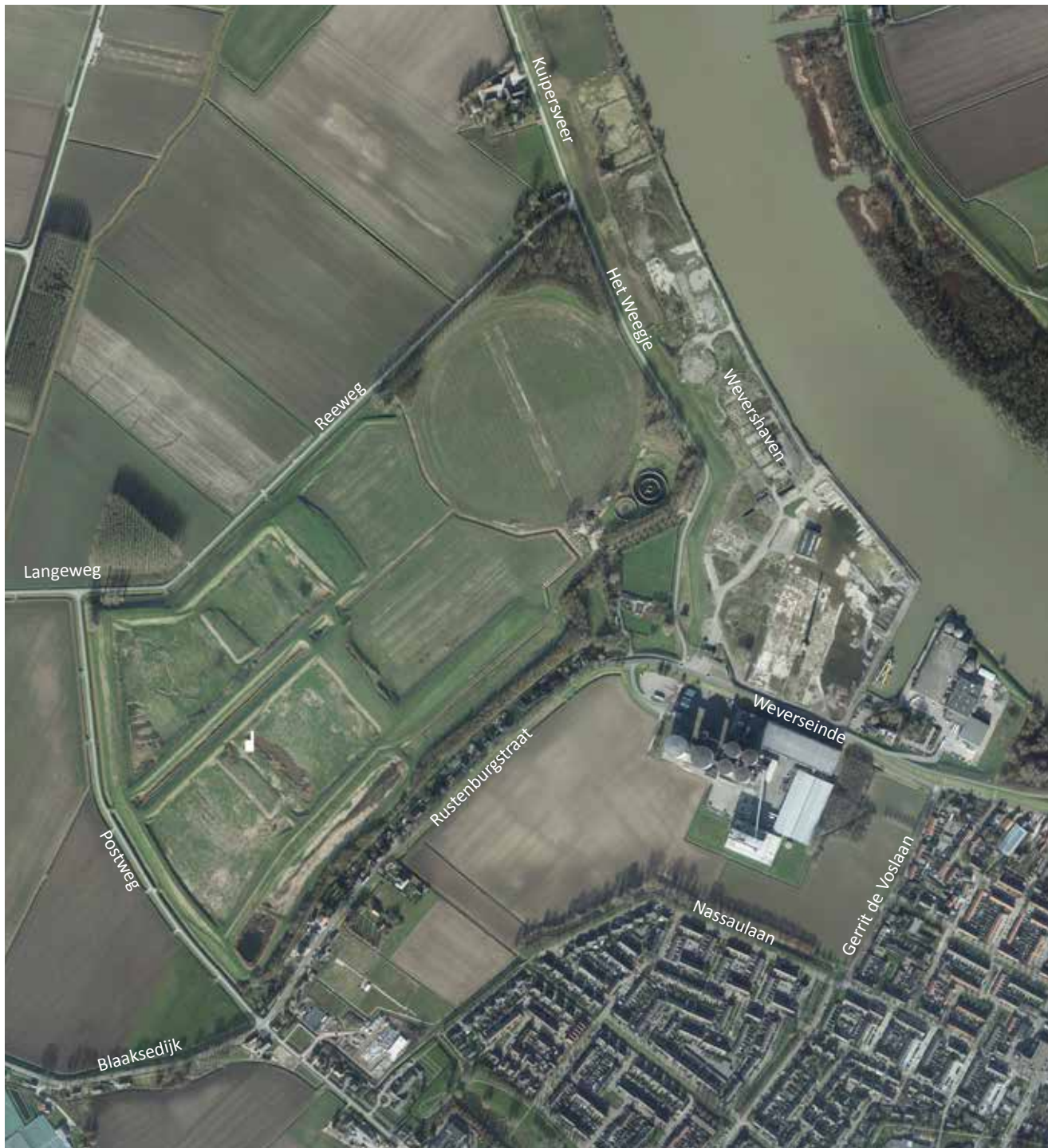
Plangebied: Bestaande situatie Suiker Unie
