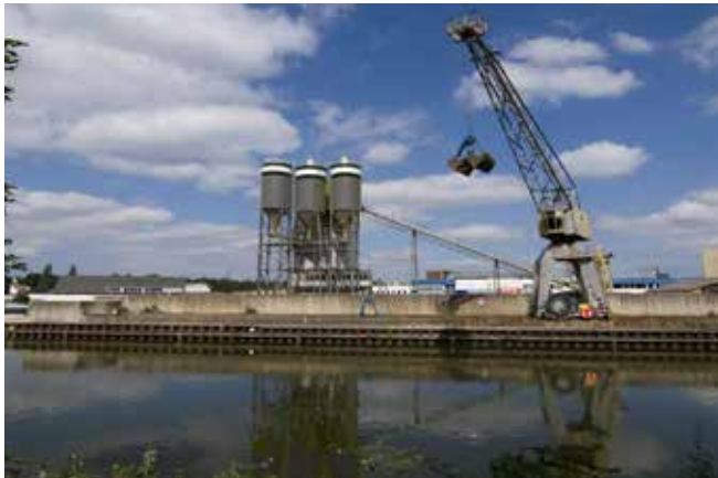
Silo's in combinatie met laad- en loskraan op de kade
