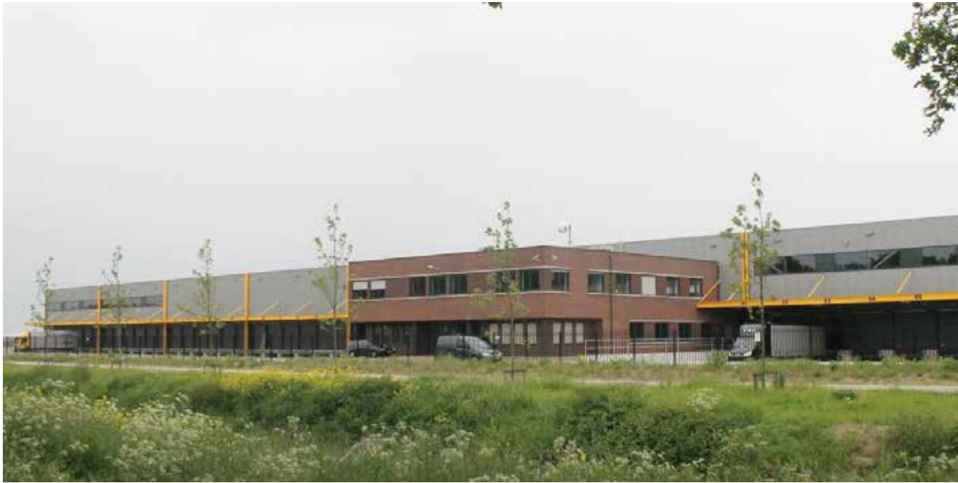
Accentuering aan de voorzijde, bedrijfshal aan de achterzijde
