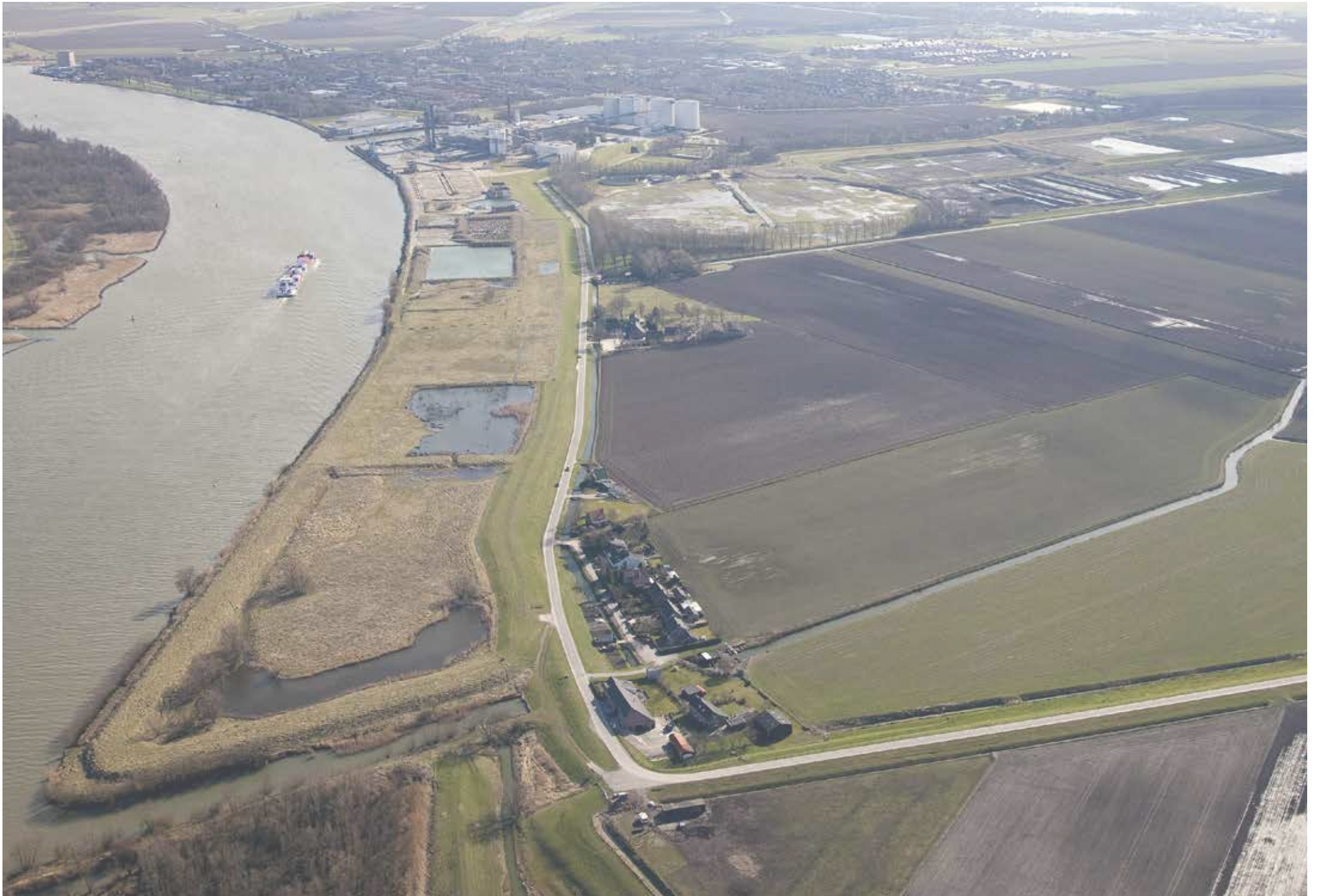
Plangebied: Luchtfoto, zicht vanaf Kuipersveer
