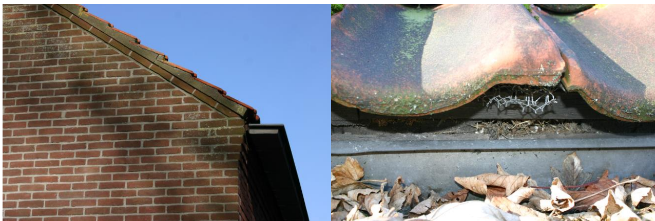
Figuur 4.5.1. Afwerking van de dakpannen aan de voorzijde (links) en zijkanten (rechts) van het woonhuis. De gevelpannen aan de voorzijde zijn met specie afgestreken en de overige dakpannen zijn afgedicht met gaas.
