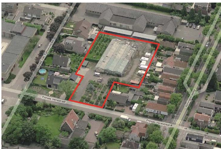
Figuur 2.2: foto bestaande situatie, de kas is inmiddels gesloopt
