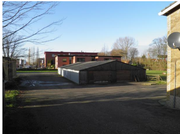
Figuur 8. Overzicht van het projectgebied vanaf de Stougjesdijk. Rechts in beeld de woning; linksachter gebouw 4 en in het midden gebouw 5. Rechtsachter is de paardenwei te zien.
