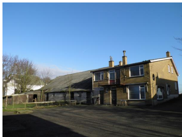
Figuur 4. Achterzijde van het woonhuis met naastgelegen schuur dat als paardenstal fungeert.
