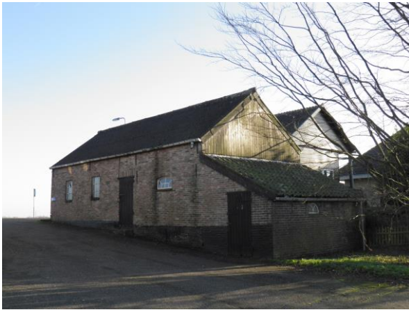
Figuur 5. De opstal langs de dijk (gebouw 3).
