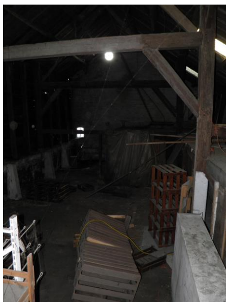
Figuur 9. Binnenruimte van gebouw 1.
