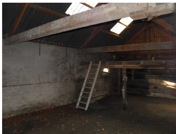
Figuur 10. Binnenruimte van gebouw 3.
