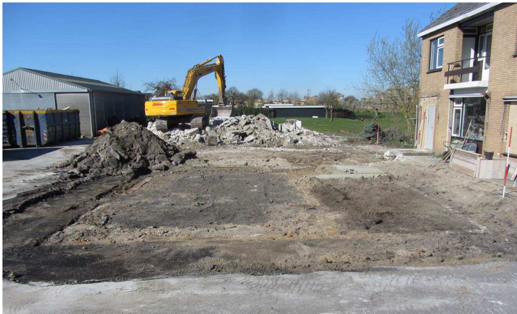
Afbeelding 11 De vierkante fundering van fase 2 gezien naar het westen. Foto: Vestigia (20-03-2014).
