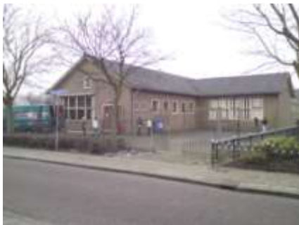
Achterzijde school (westzijde) gelegen aan de Graaf van Egmondstraat
