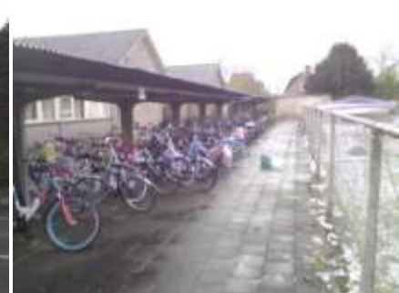
Fietsenstalling aan de noordzijde van het schoolgebouw
