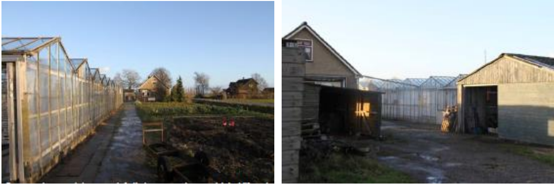
Figuur 2.2 foto's bestaande situatie
