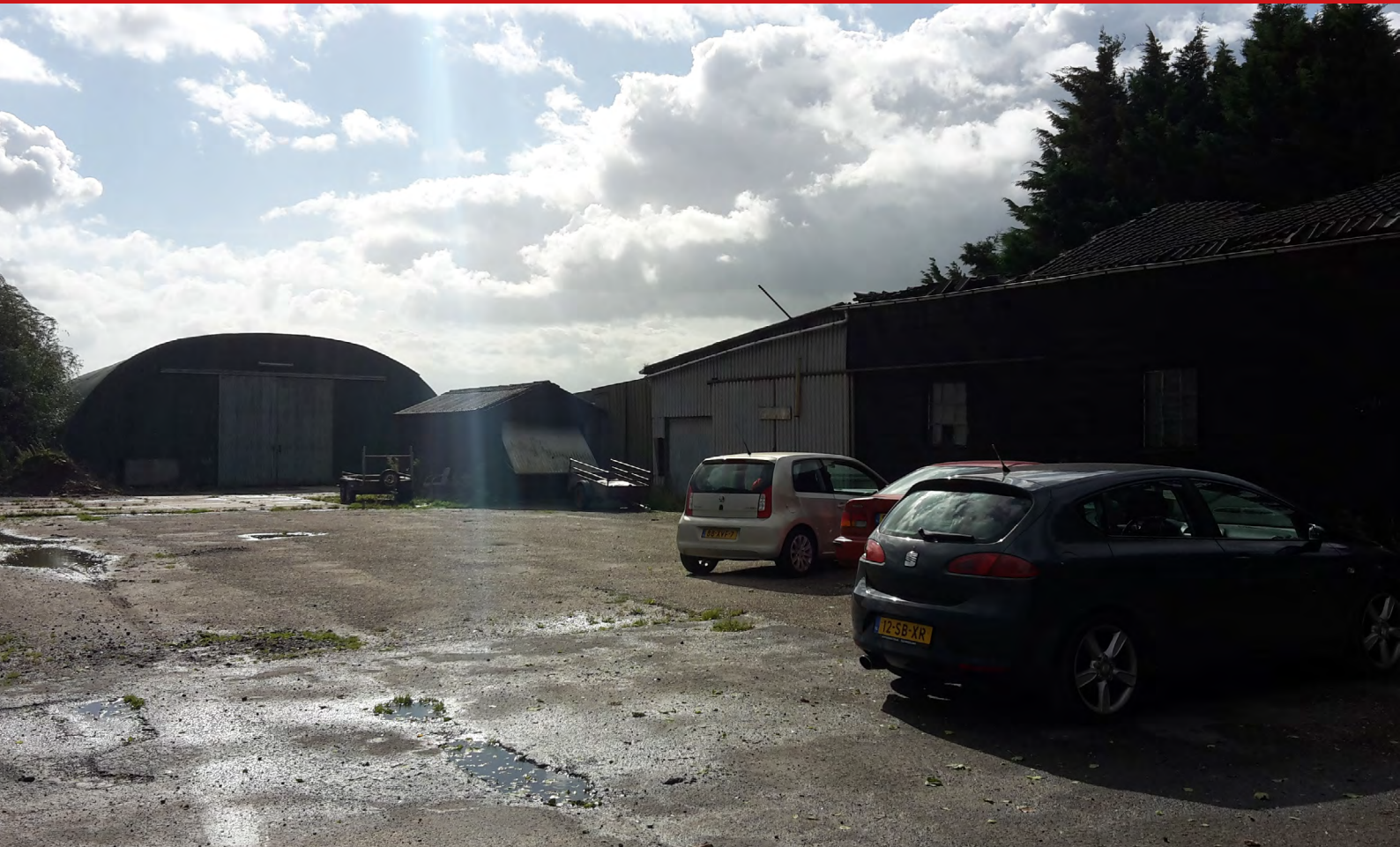
Beeldimpressie: enkele te slopen schuren
