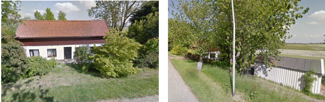
Figuur 1.4: foto's bestaande woning met bijgebouw
