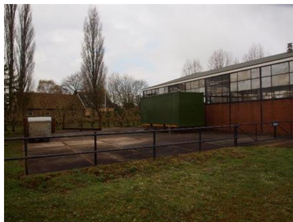
Figuur 7. Overzicht van de betonnen beplating naast de grote loods.
