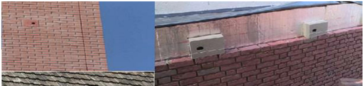
Vrijwel onzichtbare inbouw van vleermuisstenen en technische informatie over de plaatsing daarvan
