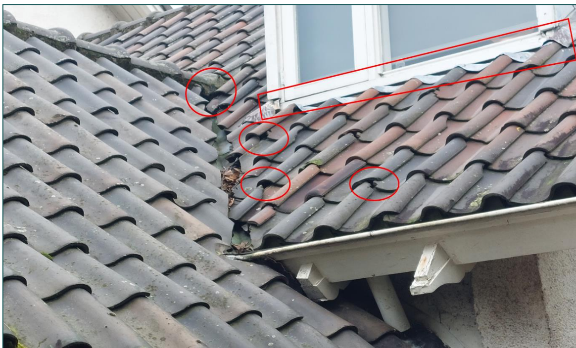
Figuur 3.3 Openingen in de woning(1) voor vleermuizen tussen dakpannen, kilgoot en onder daklood.
