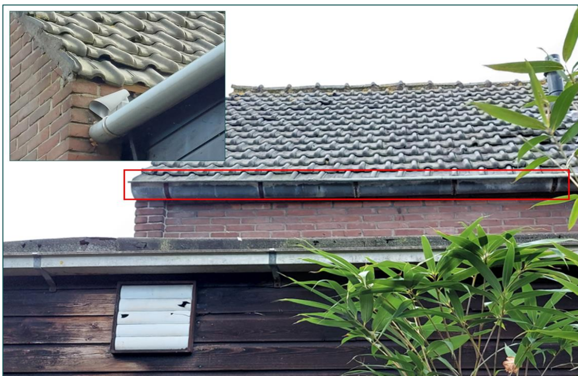
Figuur 3.7 De ruimtes tussen onderste dakpannen en dakbeschoot via de dakgoot en dakrand.
