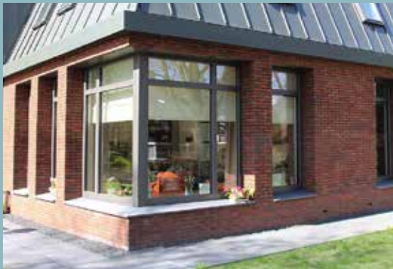
▲ hoekvensters, diepe negge
