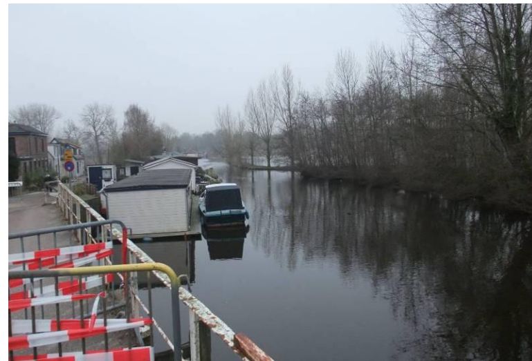
De Haarlemmertrekvaart (naar het zuiden) vanaf de even ten noorden van het plangebied gelegen Kwaakbrug. Rechts het terrein van kasteel Oud-Poelgeest. (februari 2011) (Foto: M. Lemmens, MAB)
