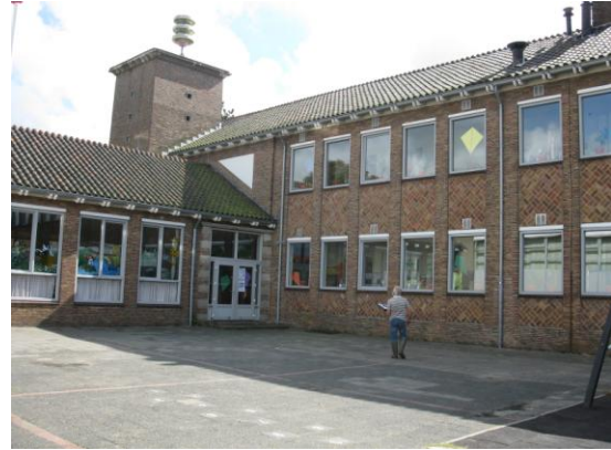
Foto 6: schoolgebouw de Egelantier
