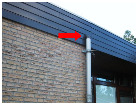
Foto 8: ruimte bij regenpijp
