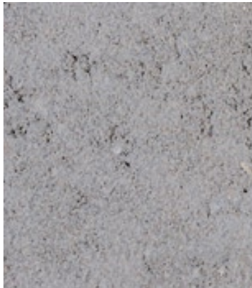
trottoir in standaard grijs beton
