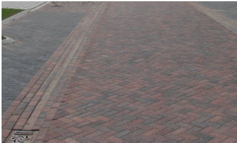
rijbaan in keperverband met molgoot
