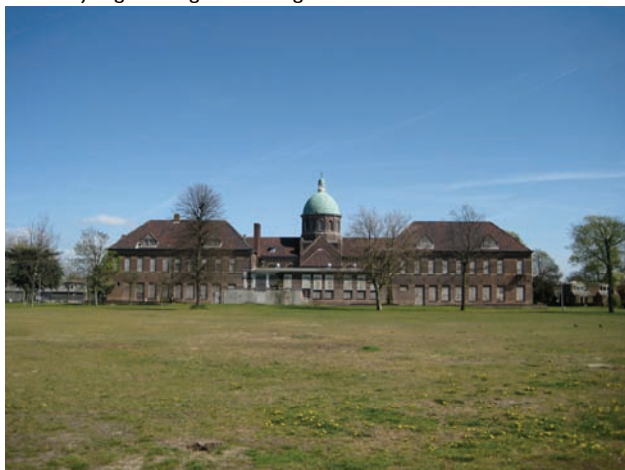
Fotonummer: 11 Omschrijving: Achterzijde hoofdgebouw (gebouw A)
