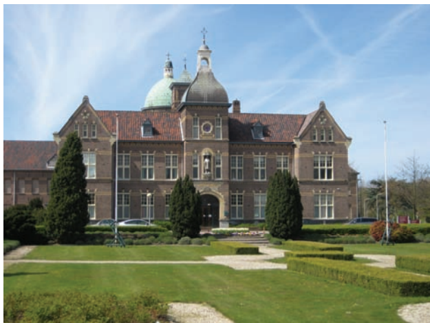
Fotonummer: 1 Omschrijving Langeveldersweg 27 (rijksmonument)
