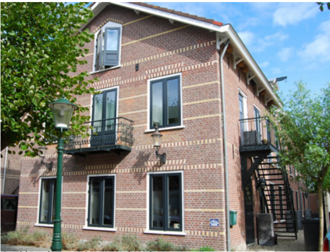
Spekbanden en siermetselwerk
