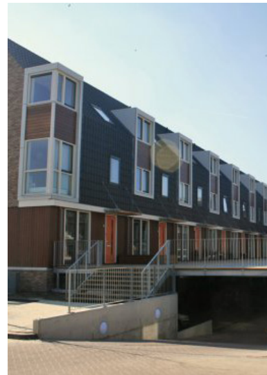
Parkeren onder ggb woningen Optis, Wierden - Schipper Douwes
