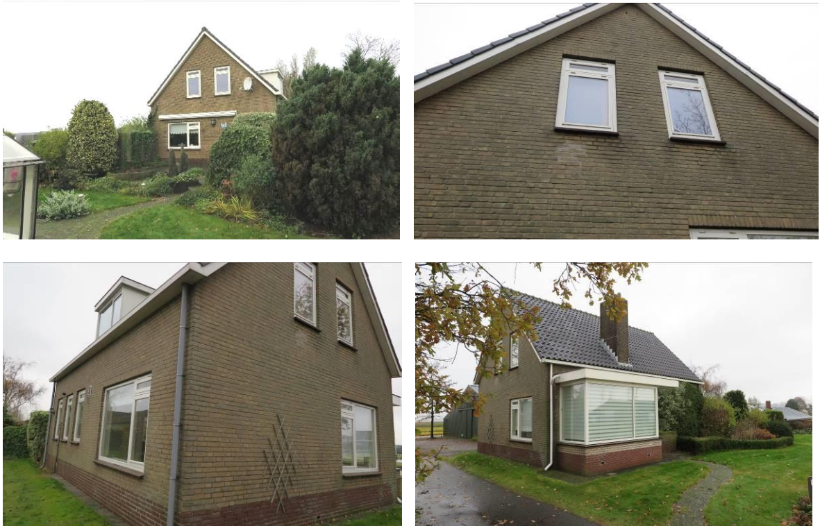
Figuur 4. Foto-impressie van de te behouden woning aan de Schippersvaartweg 69 te Noordwijkerhout.
