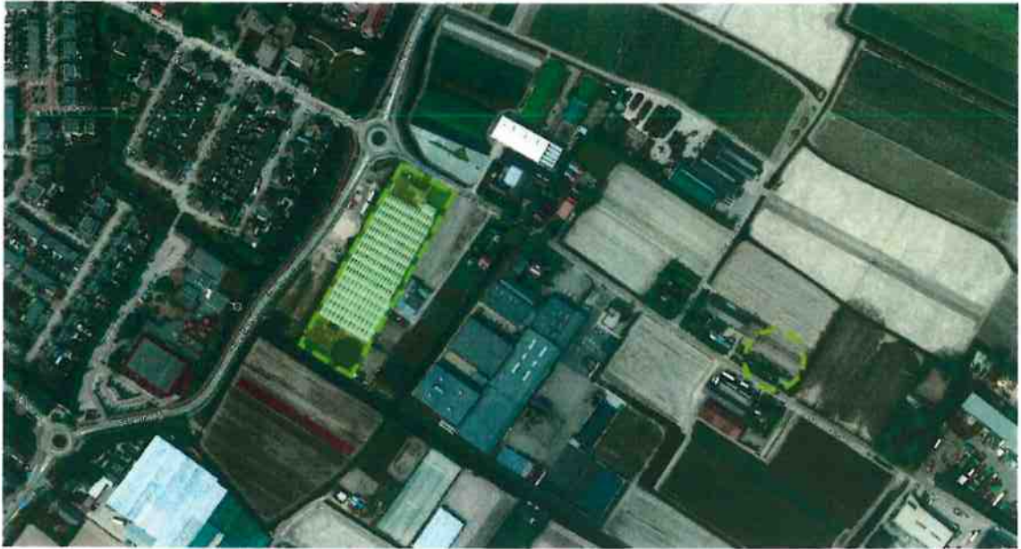
Figuur 1. Schippersvaartweg 26 en nieuwe zoeklocatie woning
