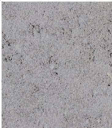
trottoir in standaard grijs beton
