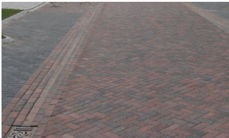
rijbaan in keperverband met molgoot
