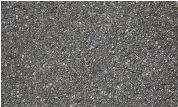
rijbaan bedrijventerrein, asfalt
