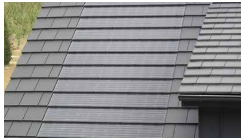
Zorgvuldig inpassen van zonnecollectoren
