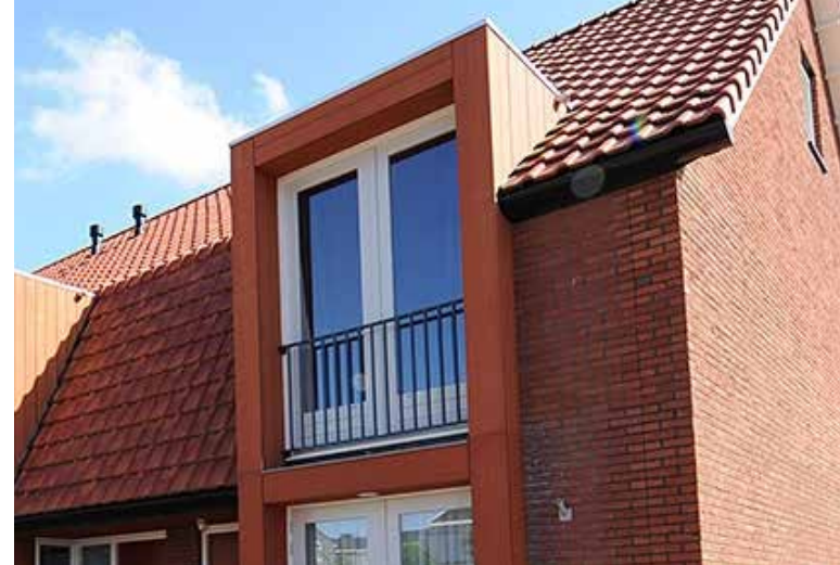
Dakkapellen vormen met de woning een eenheid
