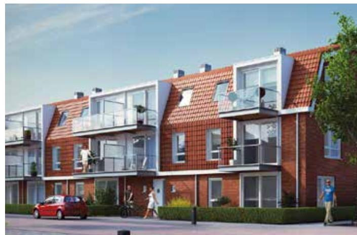
Appartementen bestaande uit 2 lagen met kap
