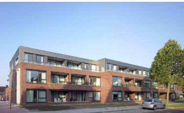
Eenvoudige hoofdvorm met horizontale geleiding
