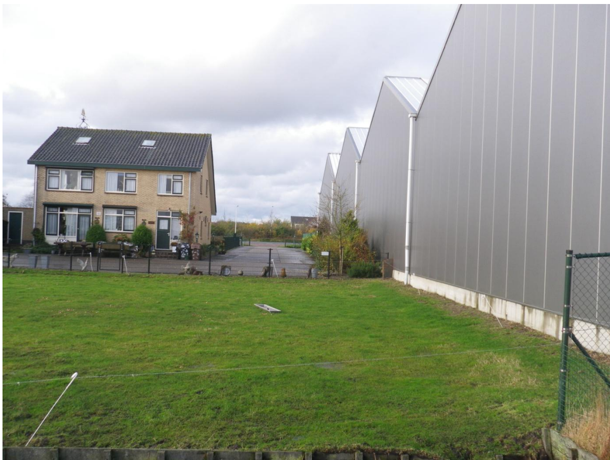
Foto 5: Herenweg 362 te Noordwijkerhout
