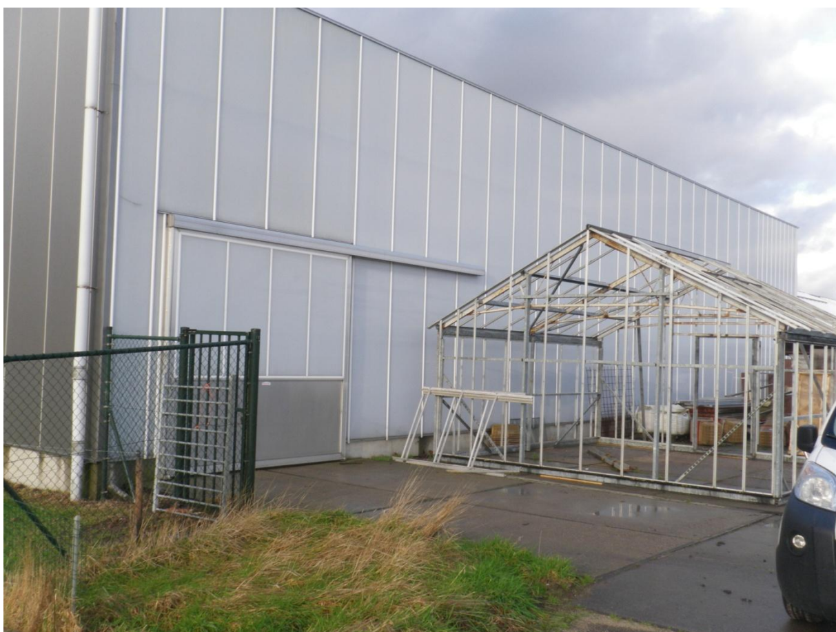
Foto 6: Herenweg 362 te Noordwijkerhout
