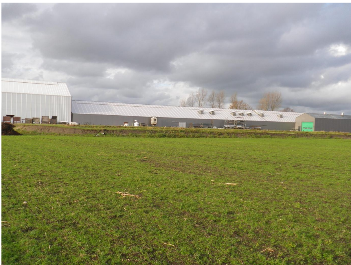
Foto 18: Herenweg 362 te Noordwijkerhout
