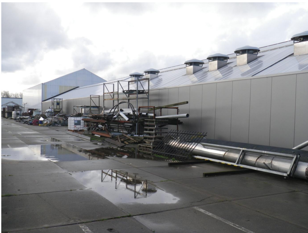
Foto 4: Herenweg 362 te Noordwijkerhout
