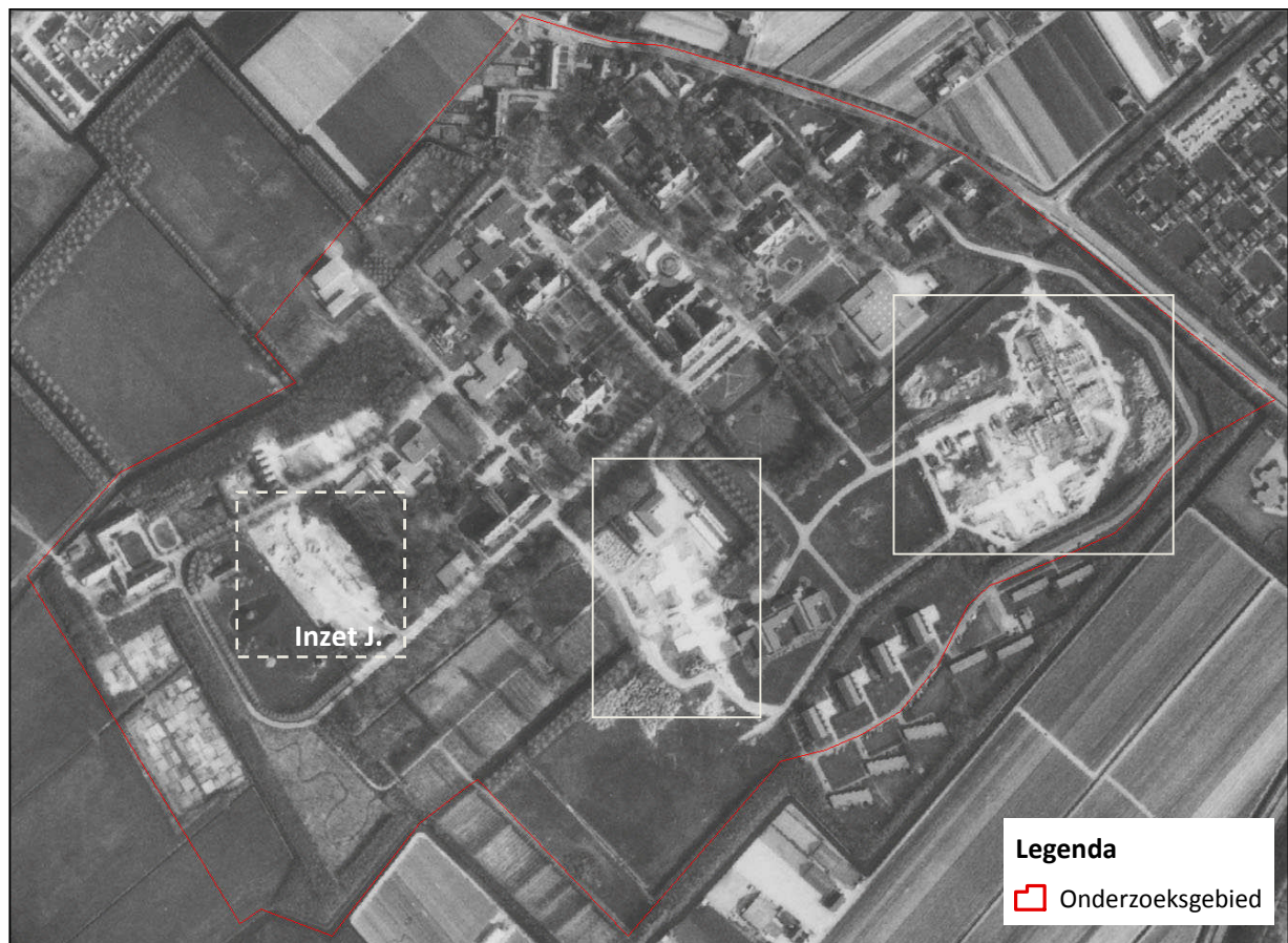
Figuur 38: Luchtfoto 24-804-1981 uit 1981. Grootchalige werkzaamheden in het onderzoeksgebied ten behoeve van nieuwbouw. Er zijn graafwerkzaamheden in uitvoering ter plaatse van het zandlichaam ( inzet J. en zie figuur 14 en 16 )
