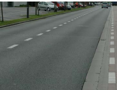
rijweg van asfalt
