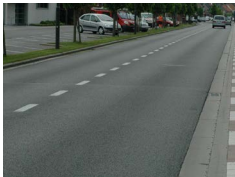
rijweg van asfalt
