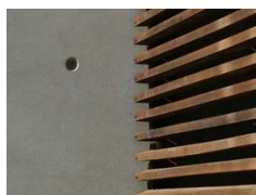
hout met ondersteuning van schoon beton
