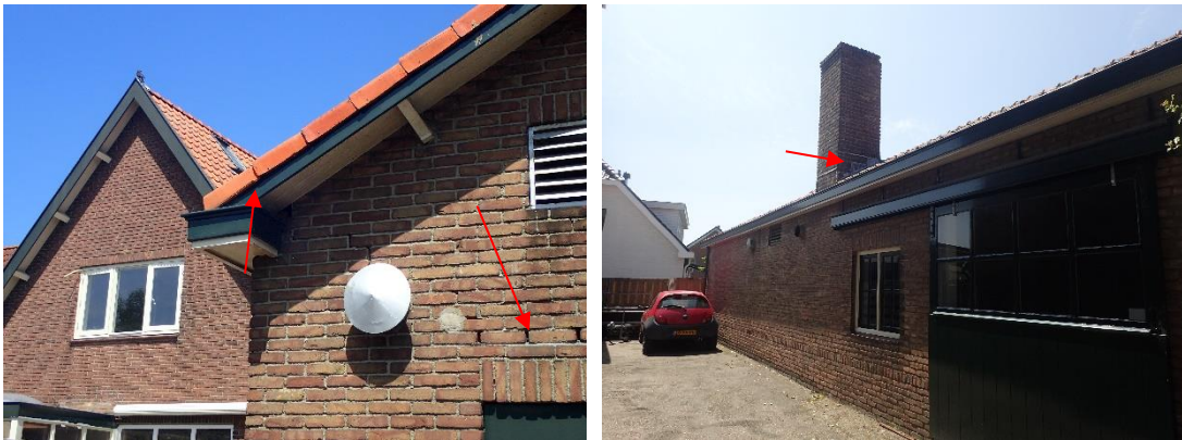
Figuur 7. Mogelijke verblijfplaatsen in het pand aan de zeestraat 83a (rode pijlen) voor gebouw-bewonende vleermuizen.
