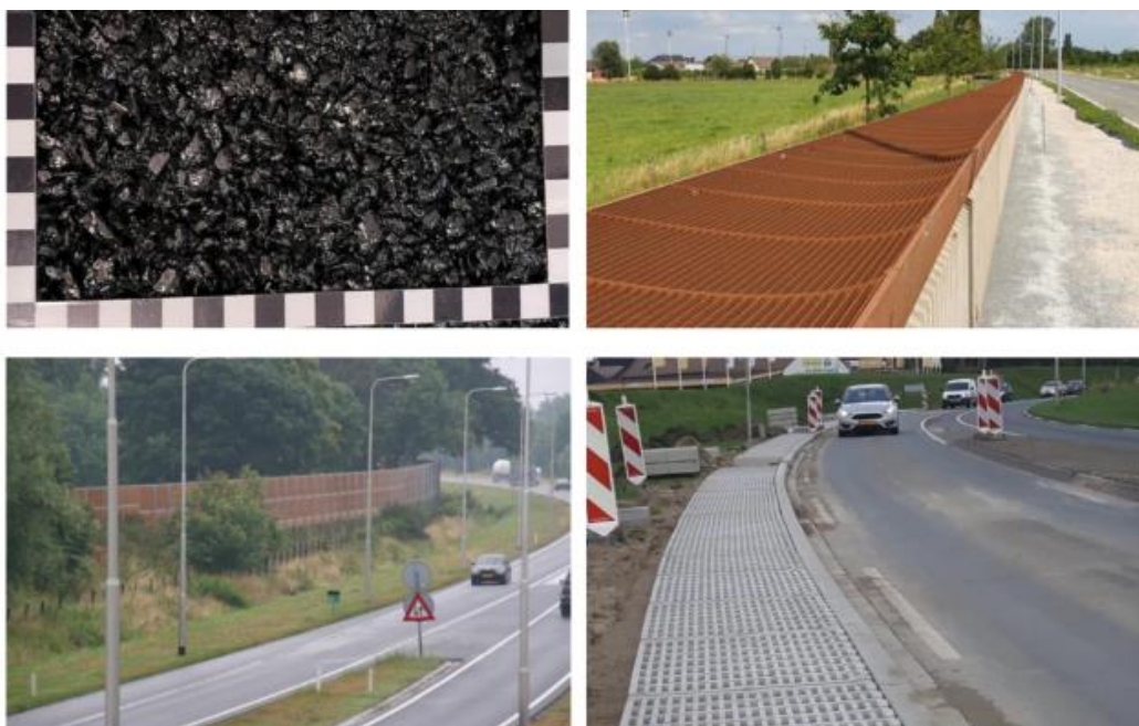
Figuur 2: voorbeelden wegdek SMA-NL8 G+, diffractorscherm (4Silence), geluidsscherm (Kokosystems), diffractor langs de weg (4silence)
