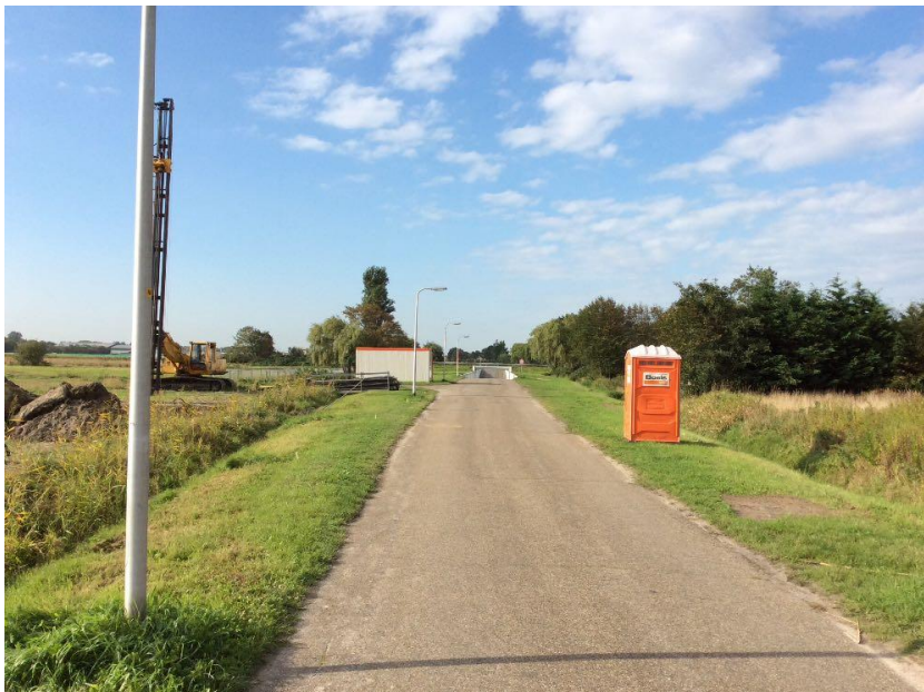
Foto 4: Locatie fundatieonderzoek en nader onderzoek PAK ter plaatse van de Achterweg, gezien vanaf de Hogeweg
