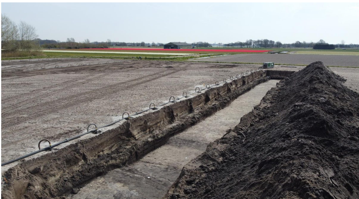
Figuur 3-3 Overzicht van het noordelijk deel van het onderzoeksgebied. Op de voorgrond is werkput 3 te zien met daarlangs de bronbemaling. De kijkrichting is het oosten.
