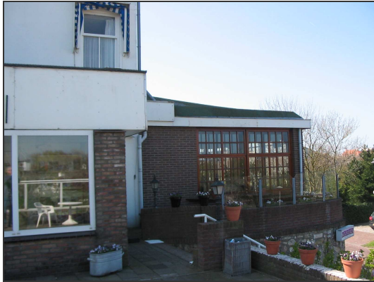
Figuur III.4 Terras en de uitbouw met daarin de grote zaal
