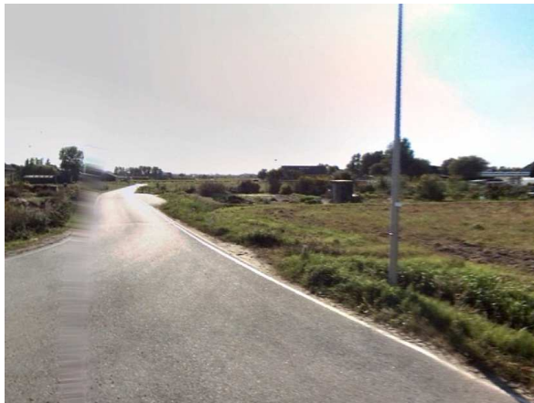
Afbeelding 3. De weg (de Achterweg) tegenover het perceel.
