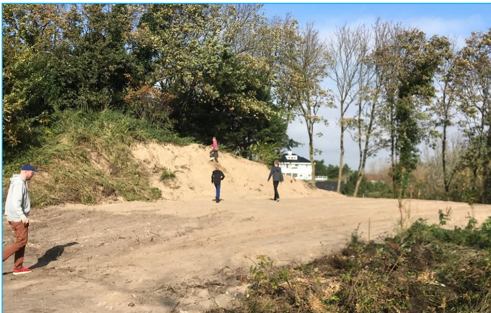
Plangebied na sloop van de villa
