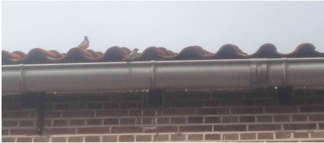
Figuur 2 Onder de dakpannen, in de goot en op de dakrand aan de voorzijde van het gebouw zijn verschillende mussen waargenomen.
