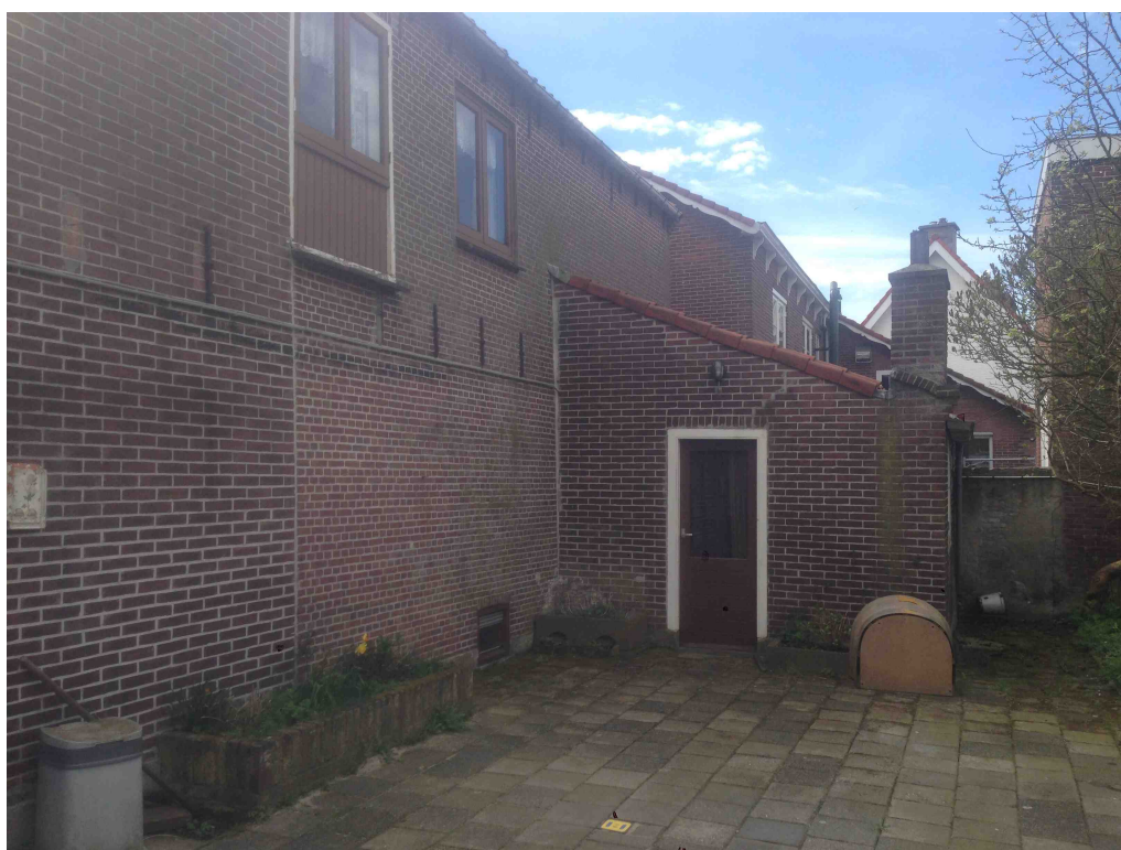
Figuur 2 De woning is een voormalige bollenschuur en verkeerd in matige staat van onderhoud. Het terras en de oprit zijn verhard met betontegels.
