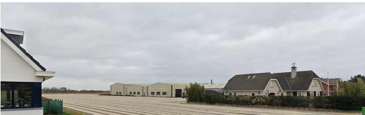
1. Zicht op de bestaande situatie ter hoogte van Westeinde 21.
