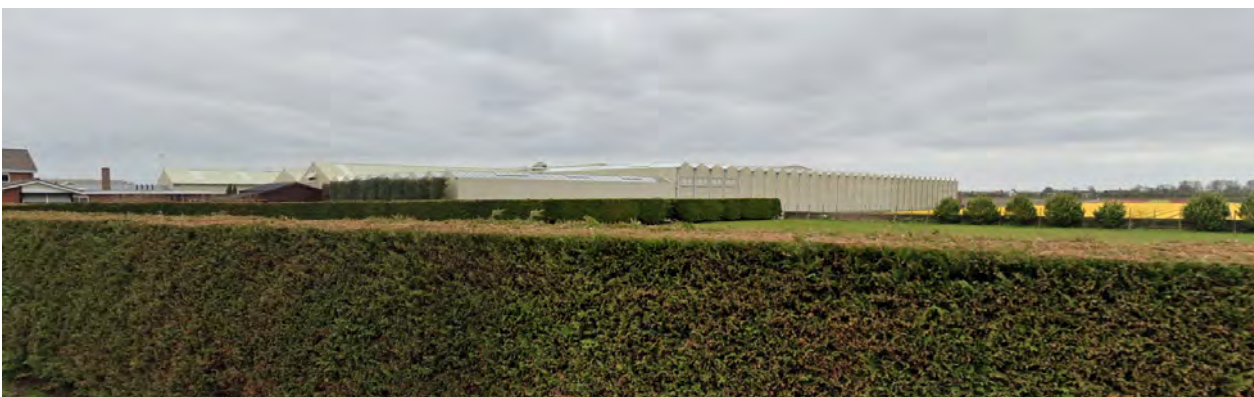
2. Zicht op de bestaande situatie ter hoogte van Westeinde 26.
