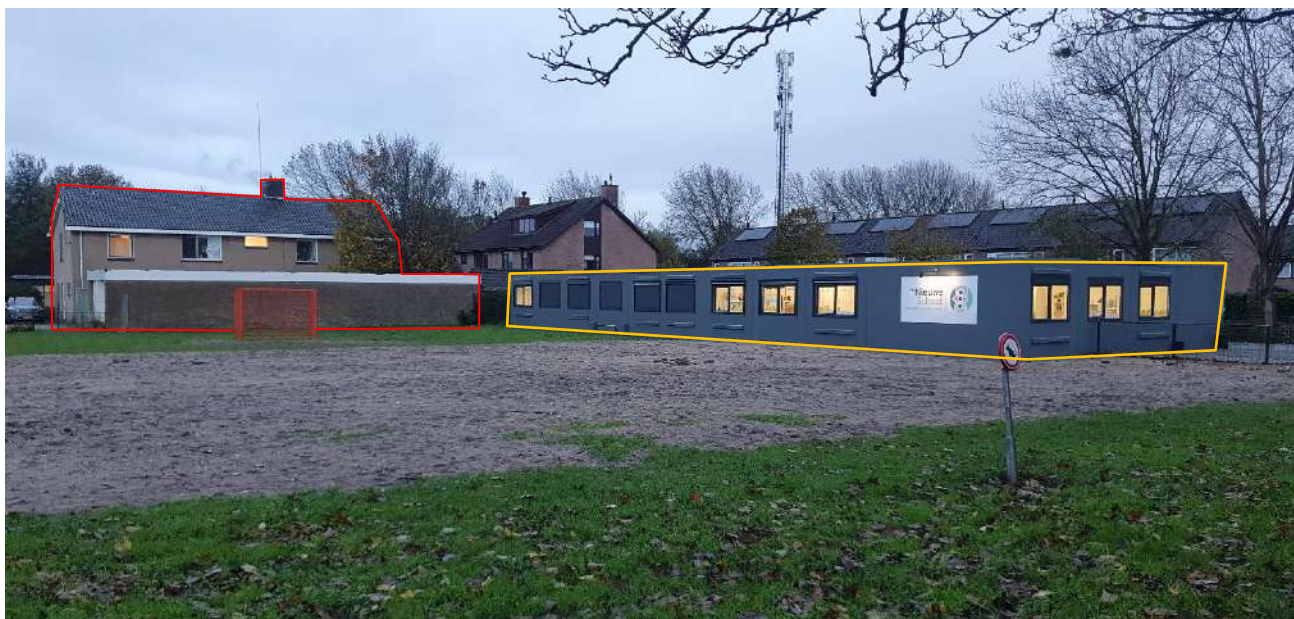
Figuur 8. Overzicht van het plangebied. Het grootste deel van het perceel bestaat uit grasveld. De gebouwen die op het perceel staan zijn rood omkaderd (Wooncomplex, Dijkzicht 1) en geel omkaderd (de Nieuwe School).
