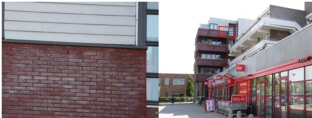
Figuur 3.1 Links open stootvoegen geschikt voor vleermuizen om verblijfplaats te betreden, rechts de plaats van de open stootvoegen boven het boodschappencentrum.
