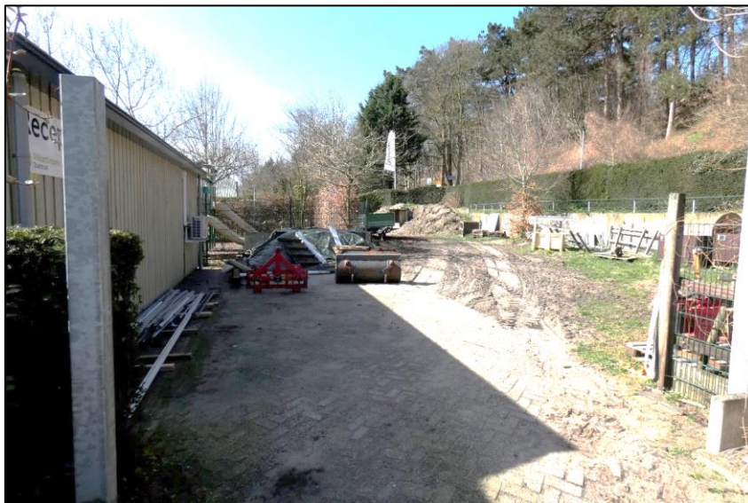
Figuur 6: Het deels braakliggende terrein wat gebruikt wordt als opslag voor materialen
