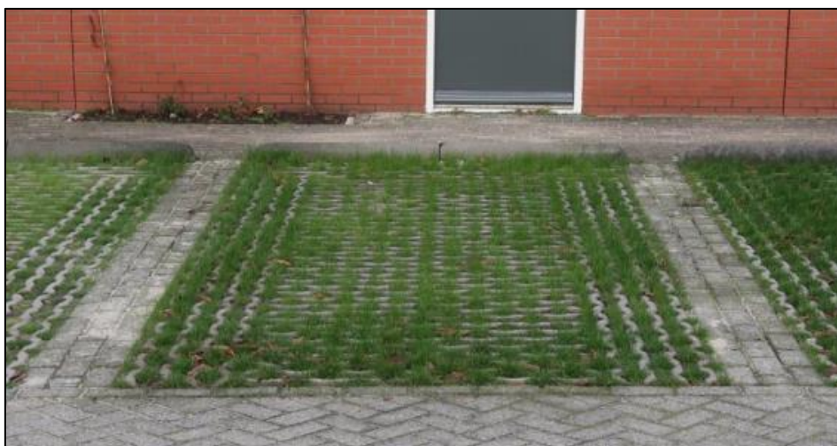
Figuur 17: Halfverharding bij parkeerplaatsen (bron:duurzaamdenhaag.nl).
