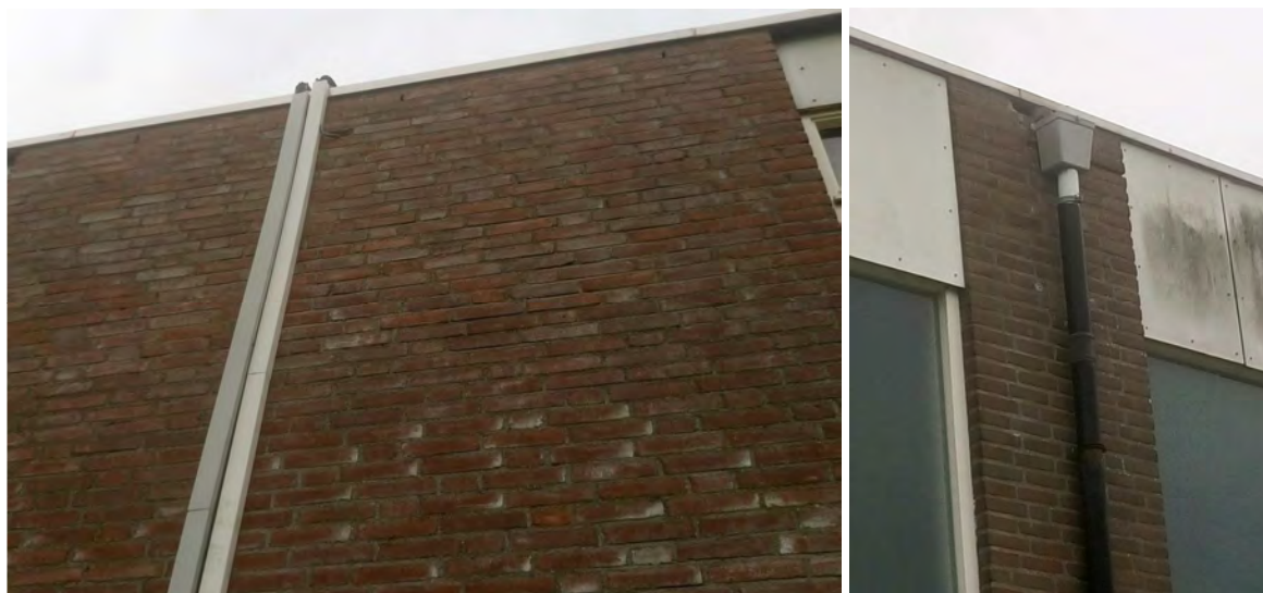
Figuur 4. Toegankelijke spouw in gebouwen sportpark
