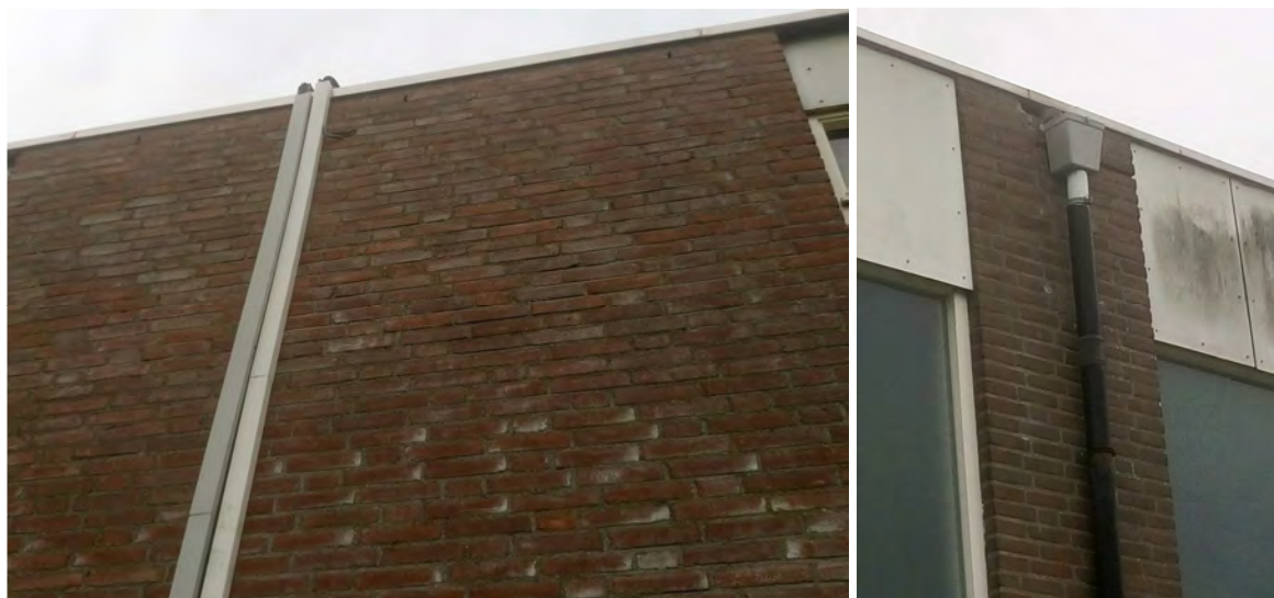
Figuur 4. Toegankelijke spouw in gebouwen sportpark
