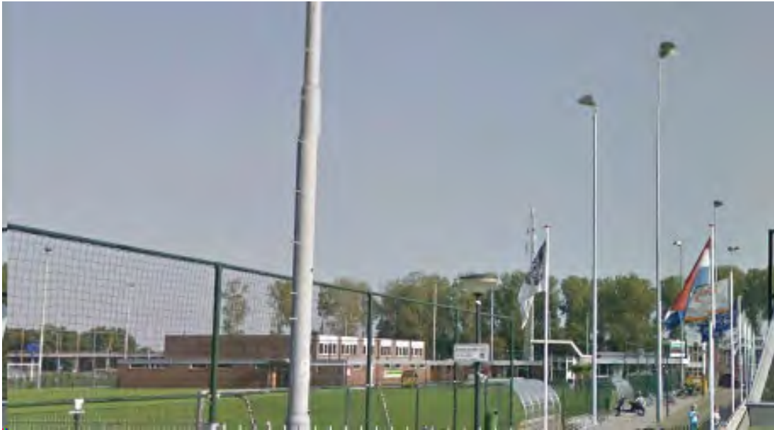
Figuur 2.2 Clubgebouw in de huidige situatie (bron: Google Maps)
