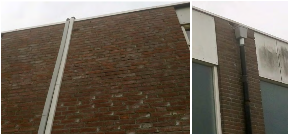
Figuur 4. Toegankelijke spouw in gebouwen sportpark
