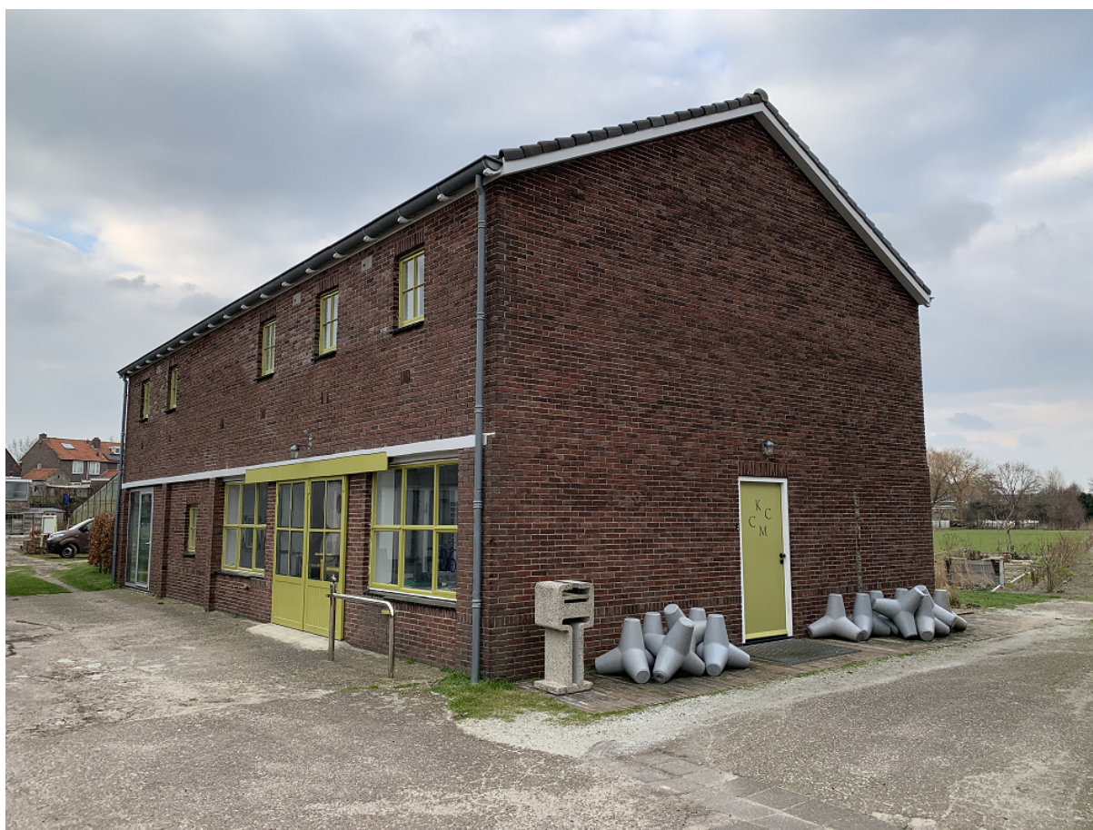
Huidige situatie van het gebouw
