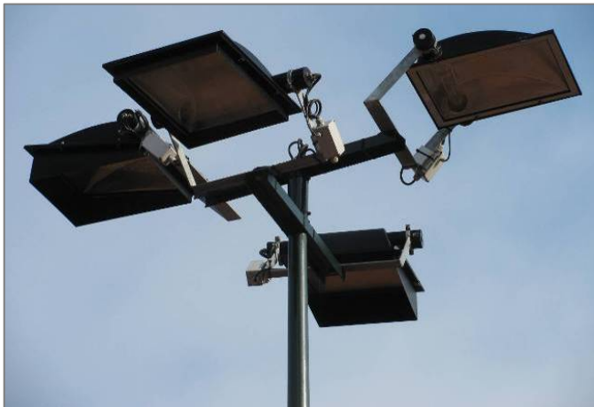
Figuur 5-1: Vleermuisvriendelijke verlichting, gedempt oranje licht, aangepaste armaturen zonder lichtverstrooiing en toepassen op korte palen.
