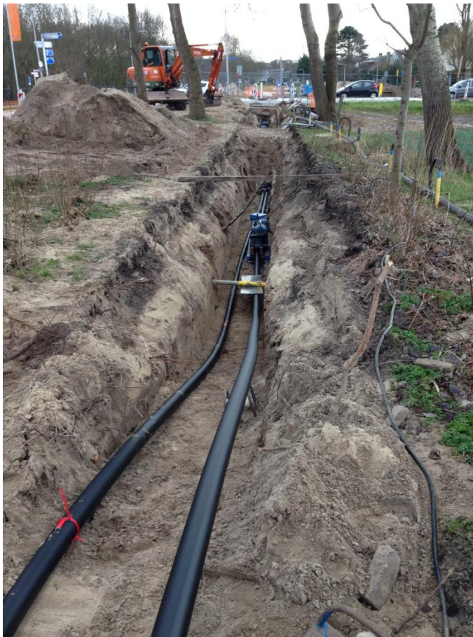
Figuur 2. Beeld van de werkzaamheden langs de Gooweg in Noordwijk tijdens de aanleg van de kabel. De zichtbare kabels (met mantels) hebben een diameter van 12,5 cm, op basis waarvan is geschat dat de sleuf een breedte heeft van ongeveer 60 cm. (foto geleverd door dhr. Van Zwieten).
